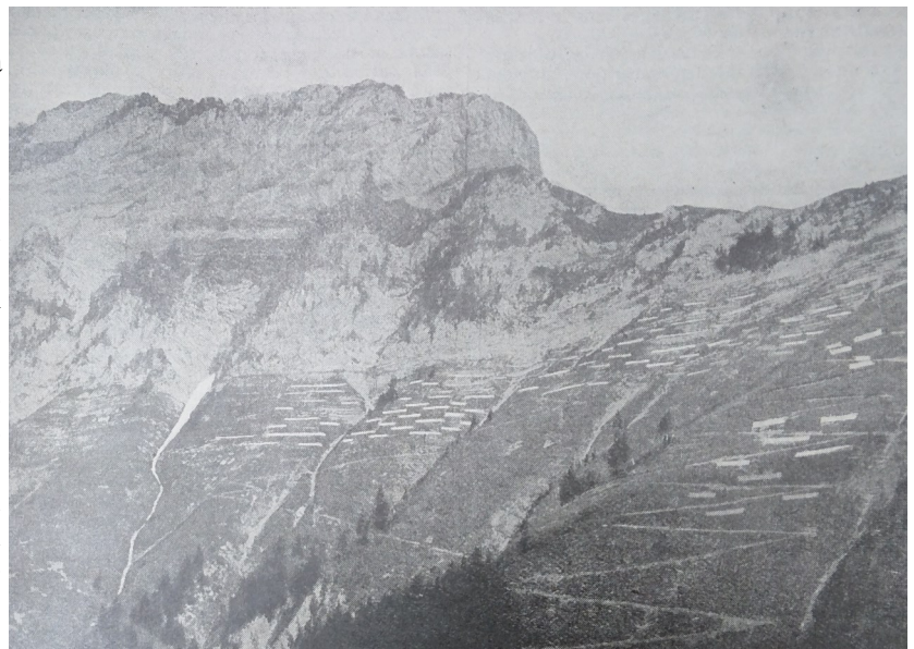
Muri e banchette antivalanga nella valle del torrente di Malnant, alta Savoia (Foto Administration des Eaux et Forêts, c. 1920, da Larousse mensuel illustré, n. 206, IV/1924)
