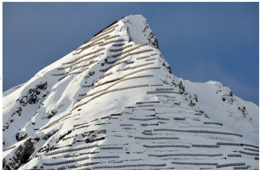
Barriere di protezione dalle valanghe nei Grigioni (M. Schiahorn, sopra Davos) (Foto Stefan Margreth, SLF, Istituto per lo studio della neve e delle valanghe)
